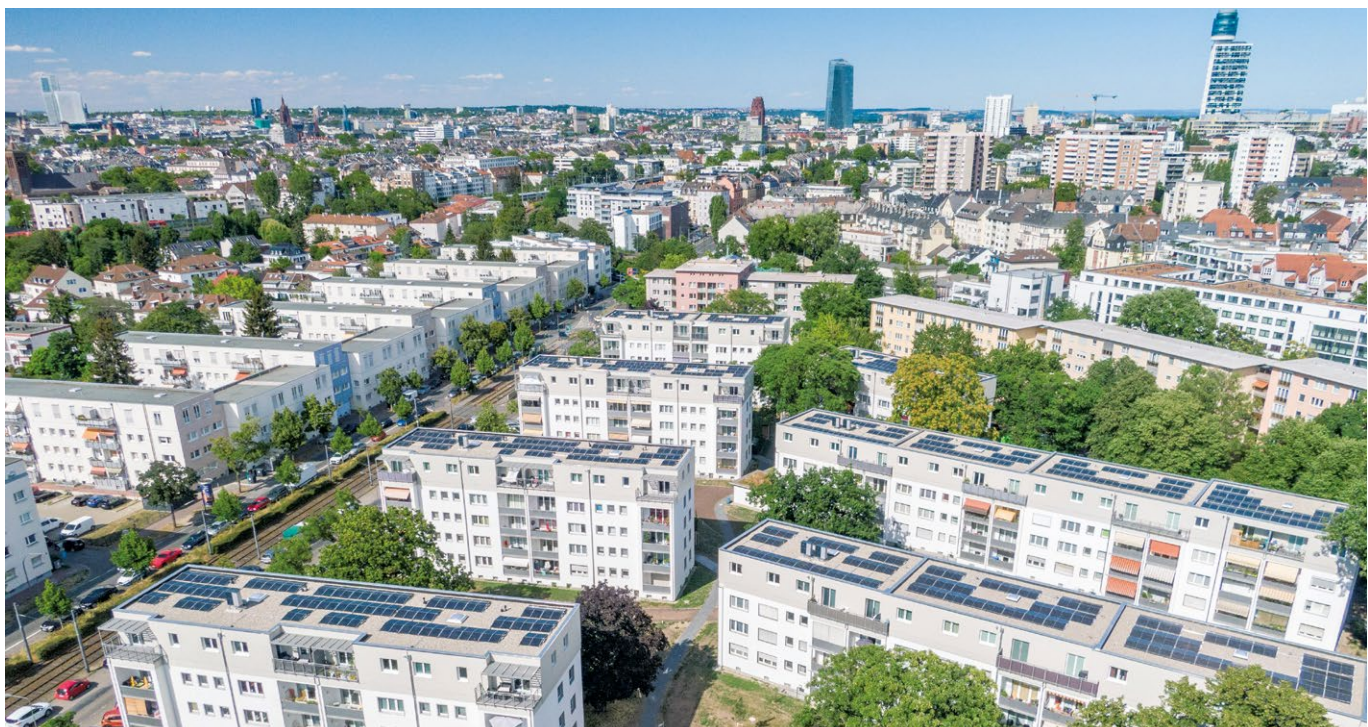
Abb. 1: Fritz-Kissel-Siedlung nach der Aufstockung in Modulbauweise (Foto: NHW/FairFleet)
