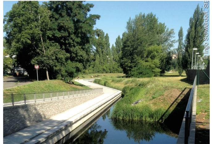
Abb. 3: Offen gestaltete Südpanke in Berlin, die die Aufenthaltsqualität erhöht und Verdunstungskühle schenkt (Foto: Ingo Schwerdorf, StEB Köln).
