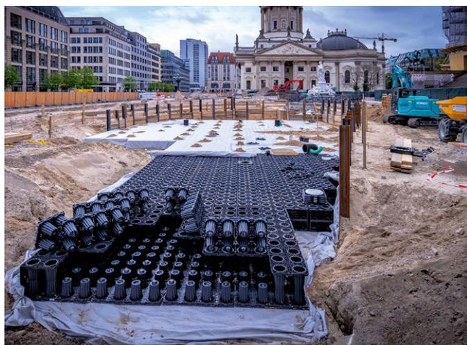
Abb. 4: Schwammstadtumbau am Gendarmenmarkt: Rigolen versickern Regenwasser (Foto: Berliner Wasserbetriebe/Sven Bock)
