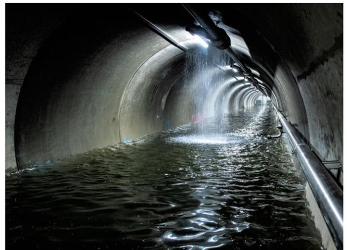
Abb. 3: 654 Meter lang unter dem Mauerpark: Stauraumkanal – Parkplatz für fast 7000 Kubikmeter Abwasser bei Starkregen (Foto: Berliner Wasserbetriebe/Benjamin Pritzkuleit)
