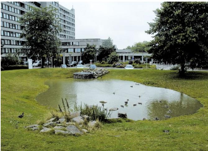
Abb. 2: Muldenversickerung Prosper-Hospital Recklinghausen (Foto: Diethelm Wulfert/EGLV)
