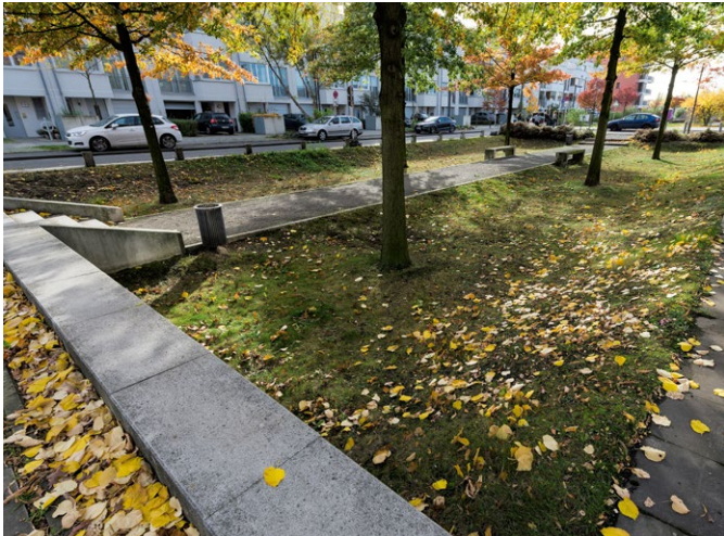
Abb. 3: Multifunktionale Fläche in der Rummelsburger Bucht. Versickerung des Straßenregenwassers und Versorgung von Stadtbäumen in der öffentlichen Grünanlage (Foto: Berliner Regenwasseragentur/Andreas [FranzXaver] Suess).
