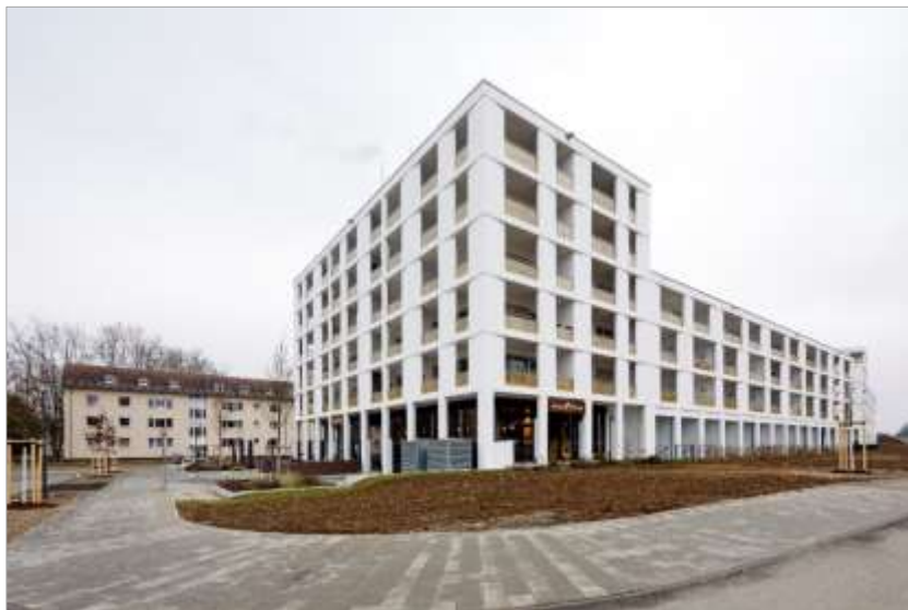
Foto: Stadt Regensburg, Effenhauser
