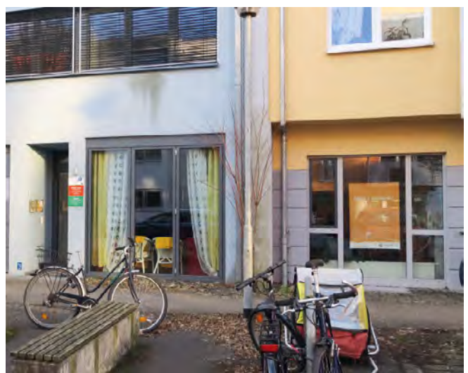
Abbildung 7: Gewerbenutzungen im Erdgeschoss (Foto: Rainer Kazig)
